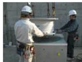
免震装置据付
